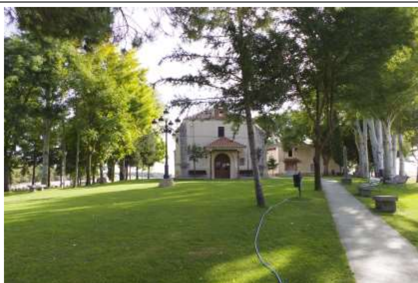
Vista del estado en que se encuentran actualmente la ermita y su entorno.
